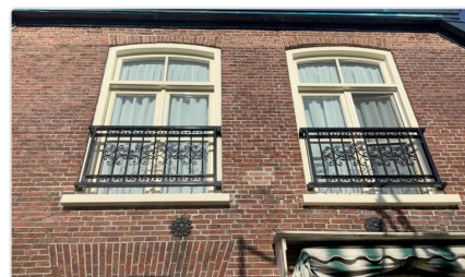
Twee hekken naast elkaar in dezelfde gevel.
