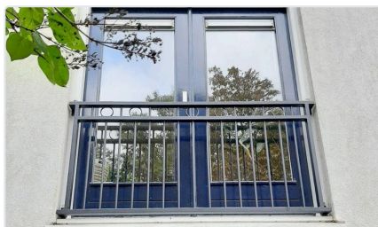
Op de dag bevestigd tussen de kozijnstijlen.
